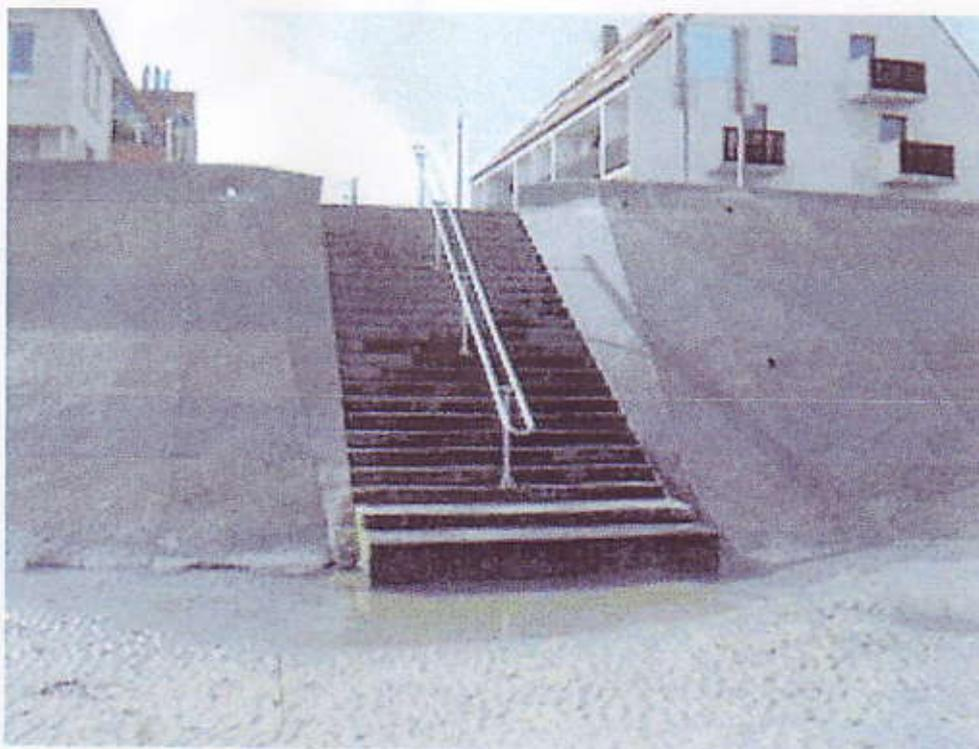
Malheureusement, la mer va continuer à attaquer le pied de la digue et aujourd'hui, le niveau de l'estran descend par endroits de plus d'un mètre, avec des variations liées au sens des vents :
