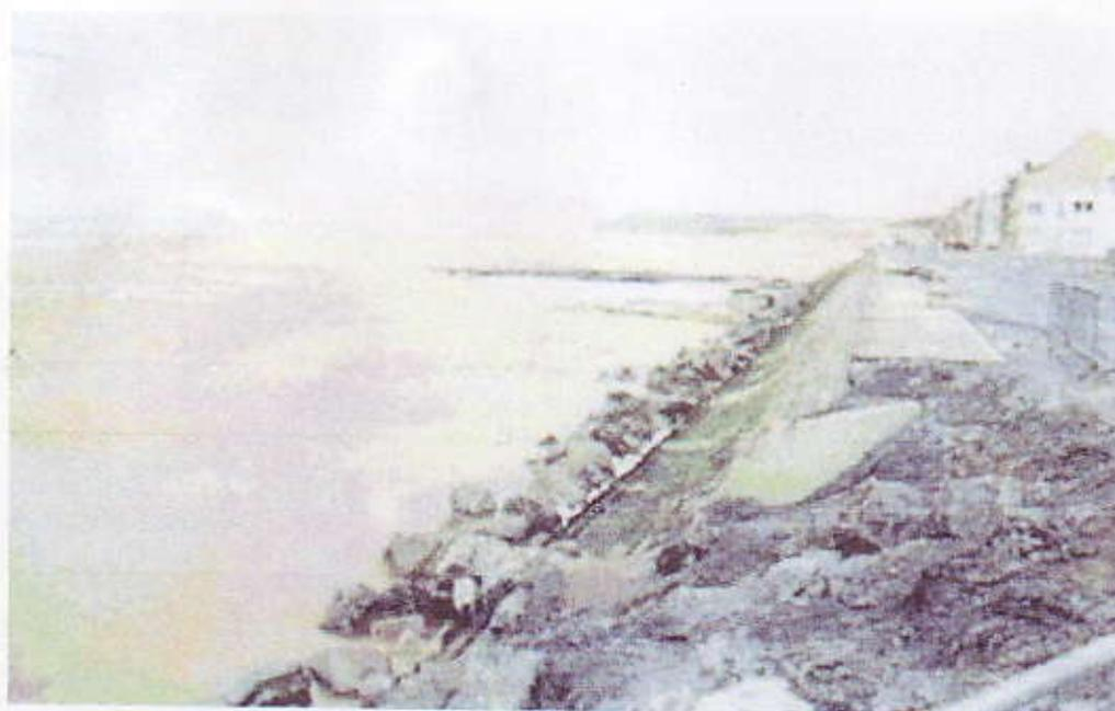
En 2000 et 2001, c'est par pans entiers que la digue va s'écrouler ; on colmate les brèches par des enrochements pour protéger les villas.
